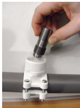
5 - Percez la canalisation avec l'emporte-pièce.
