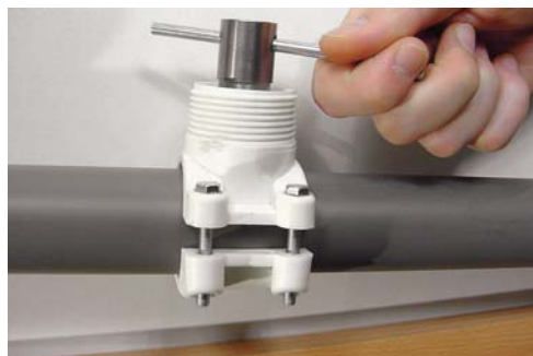
5 - Percez la canalisation avec l'emporte-pièce.
