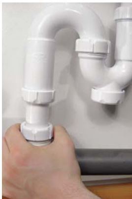
7 - Placez le joint sur le siphon.
