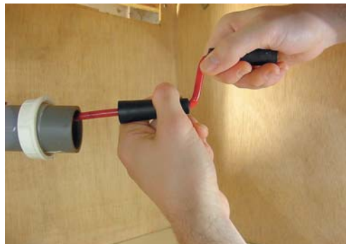
6 - Tournez la manivelle pour éliminer le bouchon.
