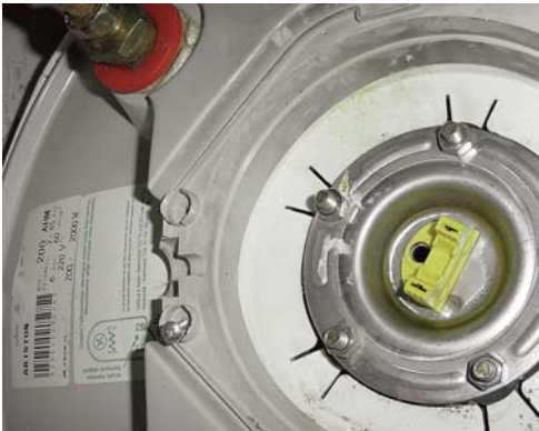
7 - Changez le joint et remontez la platine.
