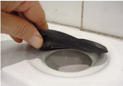
8 - Retirez le joint assurant l'étanchéité entre le réservoir de chasse et la cuvette.
