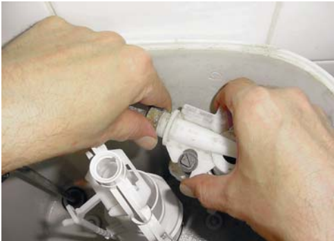
1 - Dévissez le robinet flotteur du réservoir.
