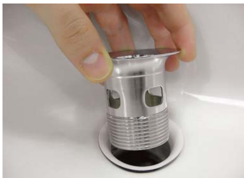
9 - Glissez l'élément supérieur de la bonde dans le trou.
