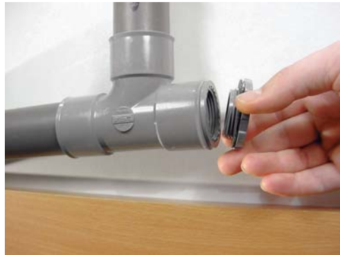
1 - Dévissez le bouchon du tampon de visite.
