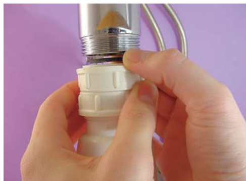
11 - Disposez le joint du siphon contre la bonde, puis vissez l'écrou en plastique.
