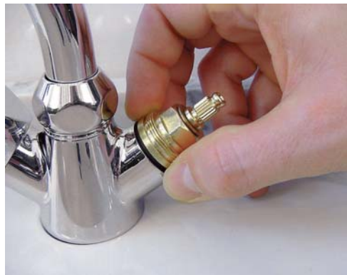
1 - Vissez la nouvelle tête avec un joint neuf.
