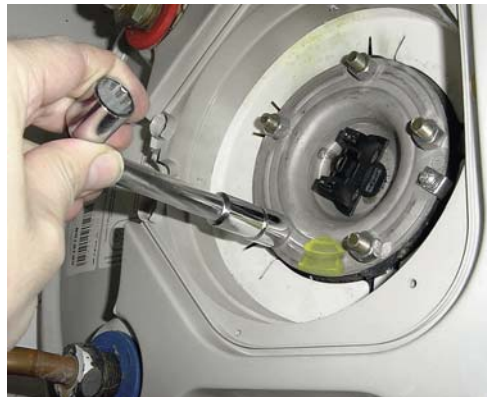
3 - Dévissez la platine électrique.
