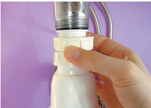
3 - Dévissez l'écrou supérieur du siphon.
