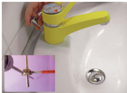
12 - Équilibrez les tiges métalliques, remontez la chape de liaison, puis vérifiez le bon fonctionnement.
