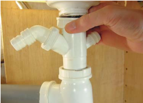
1 - Dévissez le siphon au niveau de la bonde.
