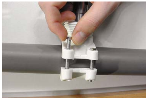
4 - Vissez la bride sur la canalisation.
