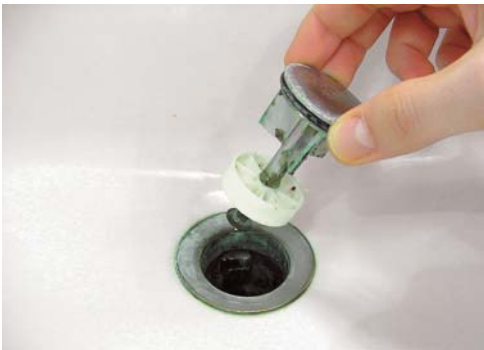
2 - Retirez le clapet de la bonde existante.
