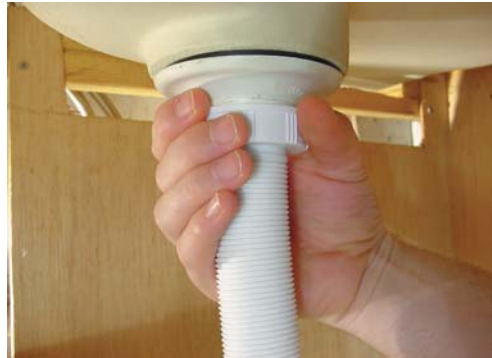
3 - Serrez l'écrou du flexible sur la bonde.
