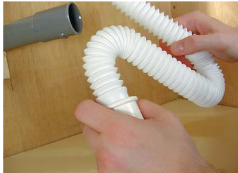
4 - Collez le manchon sur le tuyau d'évacuation et donnez une forme de siphon au flexible.
