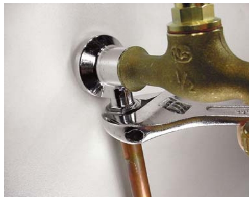
1 - Coupez l'eau, puis desserrez l'écrou.
