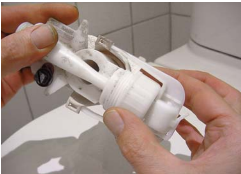
2 - Démontez la tête du robinet flotteur.
