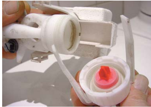
4 - Remontez la tête avec sa nouvelle membrane.
