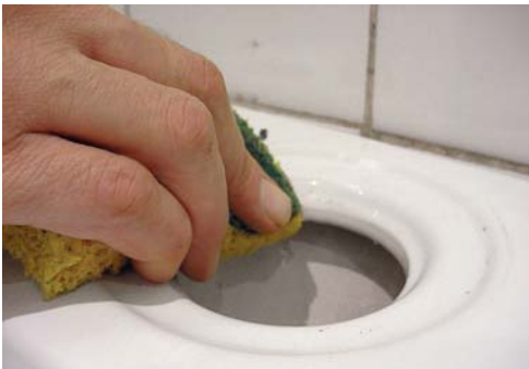
9 - Nettoyez soigneusement les parties en contact avec le joint.
