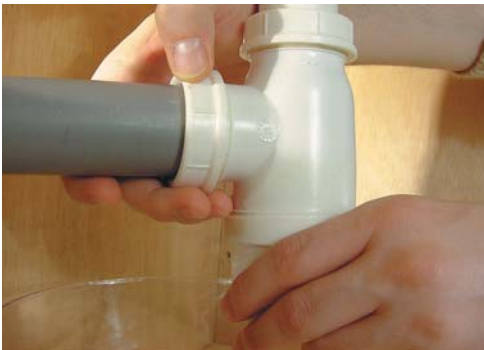
2 - Dévissez l'écrou de raccordement à l'évacuation.
