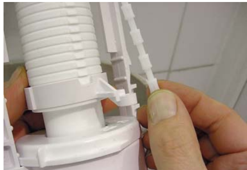
12 - Réglez le niveau du trop-plein de la nouvelle cloche, puis installez-la dans le réservoir.
