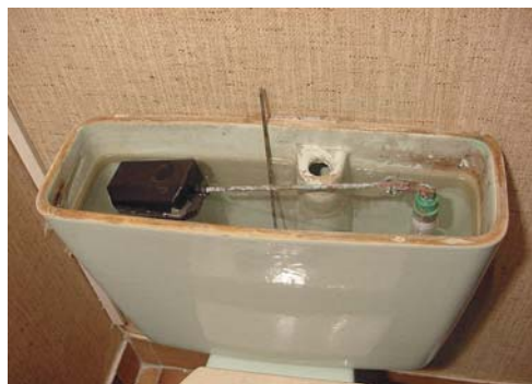
5 - Le niveau d'eau ne doit pas atteindre le trop-plein.
