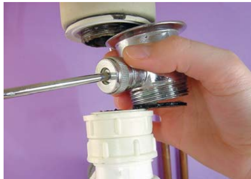
5 - Dévissez l'élément inférieur de la bonde.
