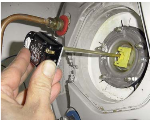
8 - Serrez les écrous en croix, installez le thermostat.
