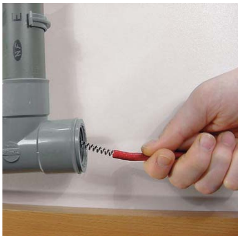
2 - Introduisez l'embout du furet dans la canalisation.
