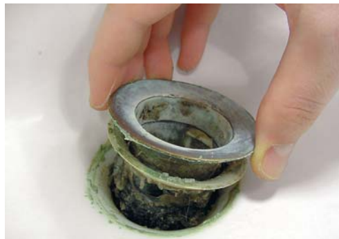
6 - Retirez l'élément supérieur de la bonde.
