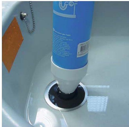
4 - Vous pouvez utiliser également la petite ventouse pour davantage de puissance.
