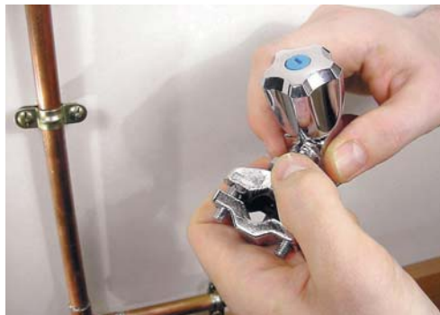
1 - Démontez la bride du robinet autopercuteur.
