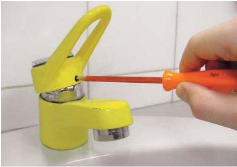
1 - Coupez l'alimentation générale d'eau. Placez la manette en position haute, puis démontez-la.
