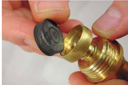
4 - Retournez le clapet ou remplacez-le par un modèle de diamètre et d'épaisseur identiques.
