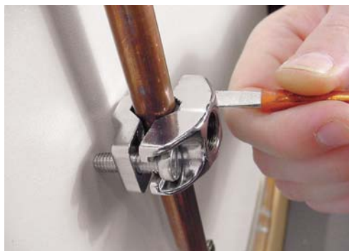
2 - Installez la bride sur une canalisation d'eau froide.
