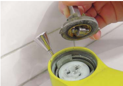
3 - Retirez le mécanisme de commande pour accéder aux disques céramiques.
