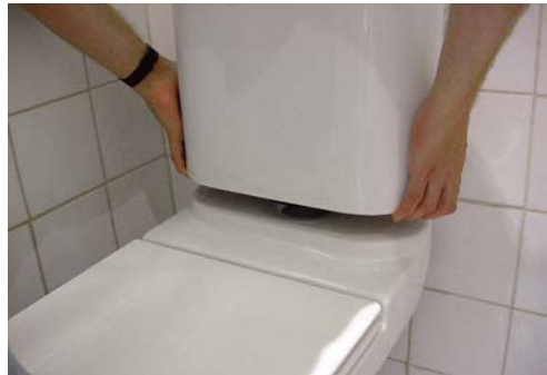
11 - Remettez en place le réservoir. Serrez les vis de fixation et raccordez l'arrivée d'eau.
