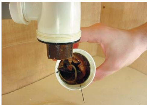
3 - Nettoyez le culot et l'intérieur du siphon.
