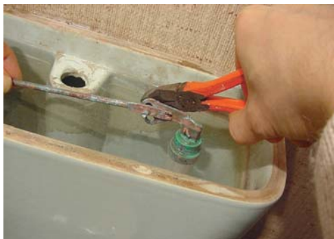
3 - Serrez l'écrou de réglage.
